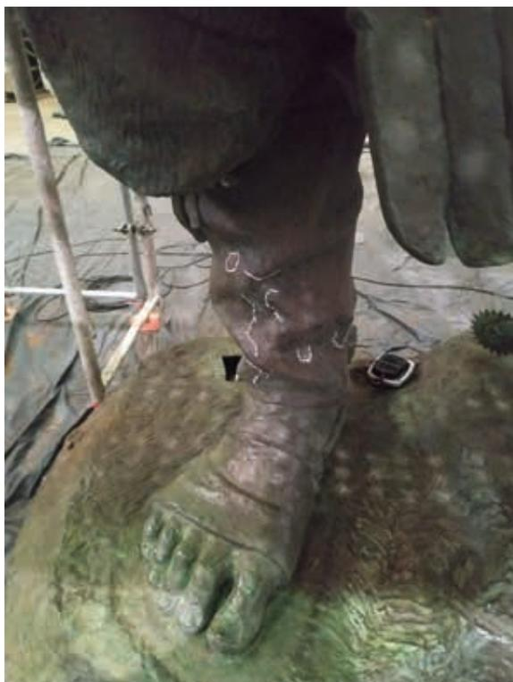
A solda tipo Tig (Tungsten Inert Gás) é o processo mais adequado para o trabalho realizado, utilizando um eletrodo sólido de tungstênio não consumível. O eletrodo, o arco e a área em volta da poça de fusão da solda são protegidos por uma atmosfera de gás inerte. O metal de enchimento necessário, no caso, o bronze, é adicionado no limite da poça de fusão, corrigindo as falhas encontradas de forma limpa e com alta qualidade, sem a produção de escória.
