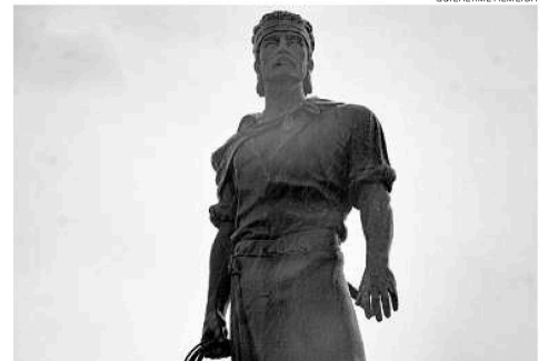
Estátua apresenta uma série de fissuras e problemas na sua fixação
