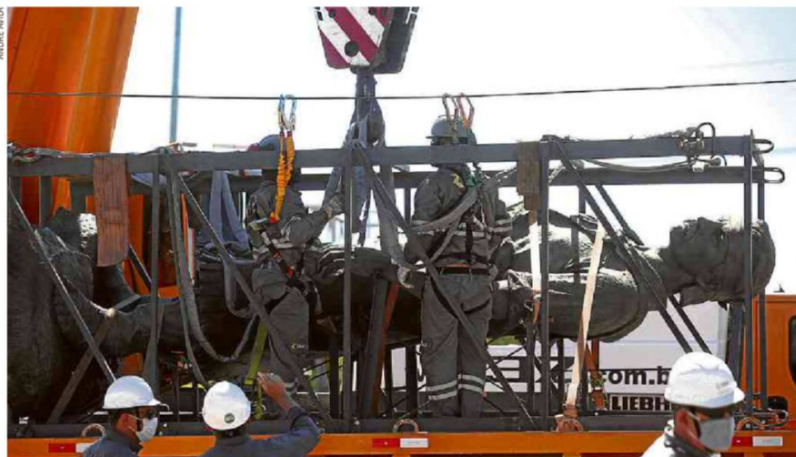
Monumento foi conduzido deitado até chegar ao sítio, onde foi içado e recolocado no lugar
