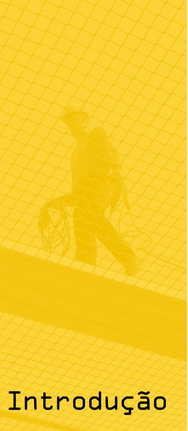
As Redes de Segurança são utilizadas como dispositivos destinados a impedir a queda de pessoas durante o processo de construção de edifícios, estruturas metálicas, pré-moldados, etc.
